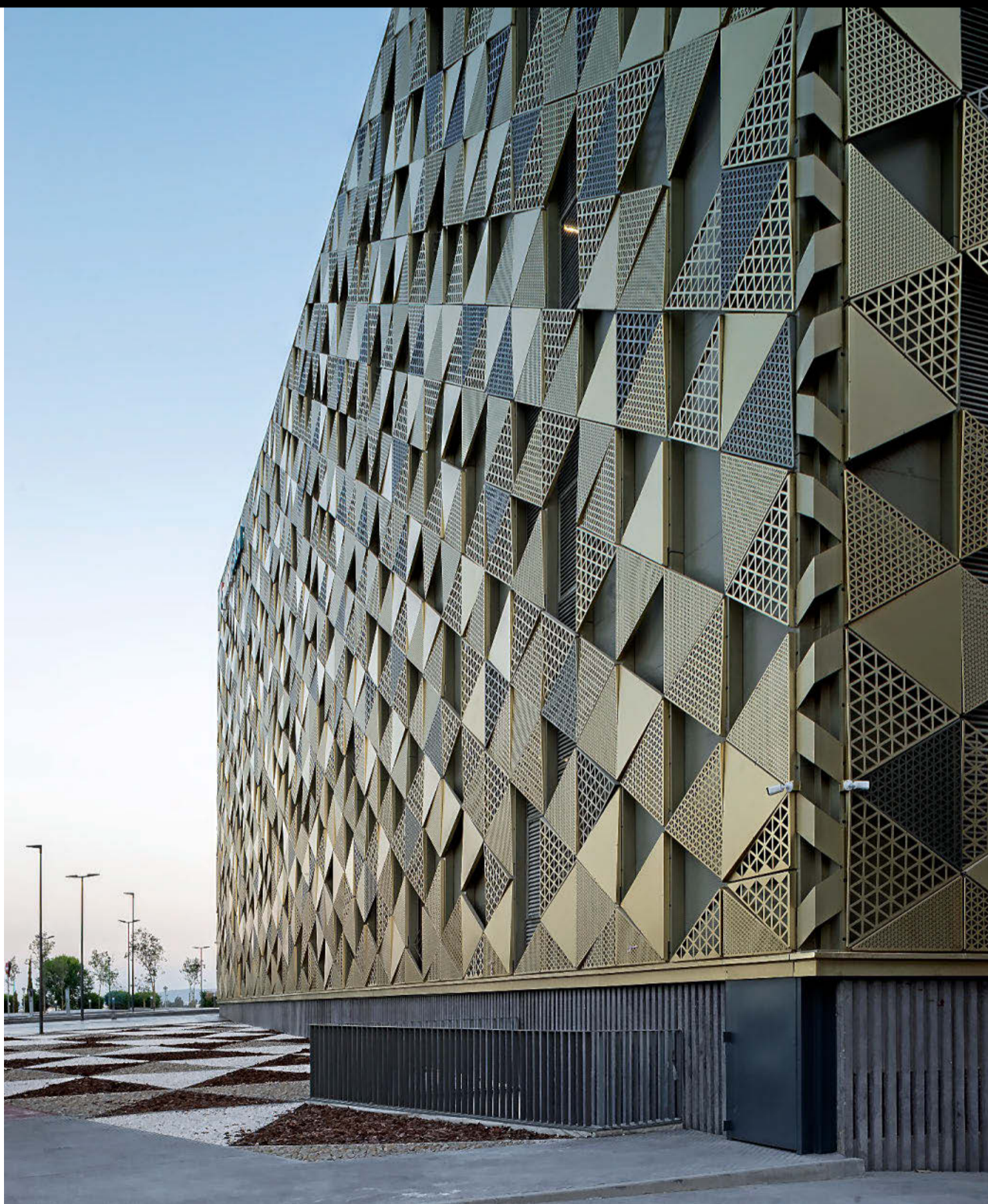
HOSPITAL DE CÓRDOBA. Una celosía metálica, que ayuda a matizar la luz, recubre el exterior del centro, dividido en dos volúmenes de distinto tamaño. ENERO ARQUITECTURA / JORGE ALLENDE
